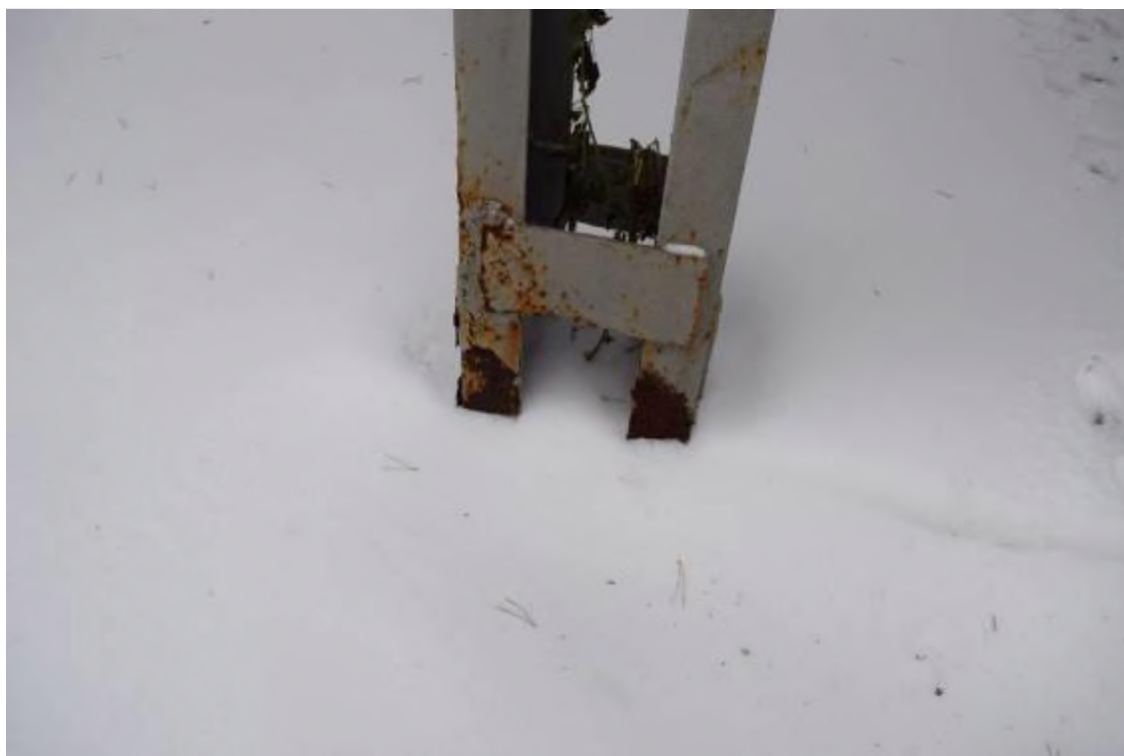
Фото 11. Коррозионное повреждение опор галереи.
