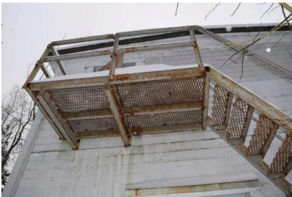
Фото 12. Коррозионное повреждение наружной лестницы.
