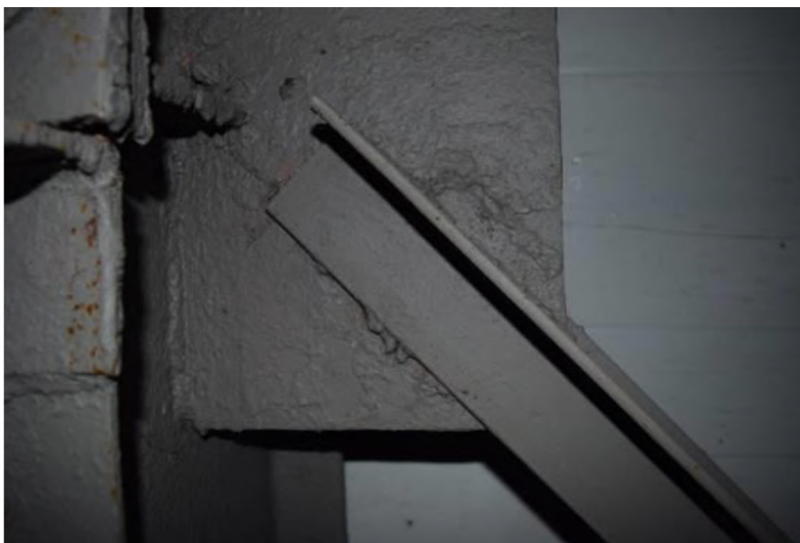
Фото 10. Дефекты сварных соединений металлоконструкций.
