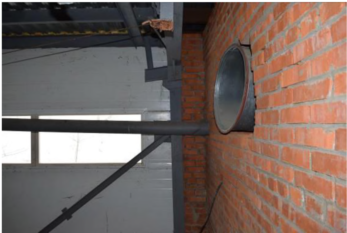
Фото 17. Перекосы металлоконструкций.
