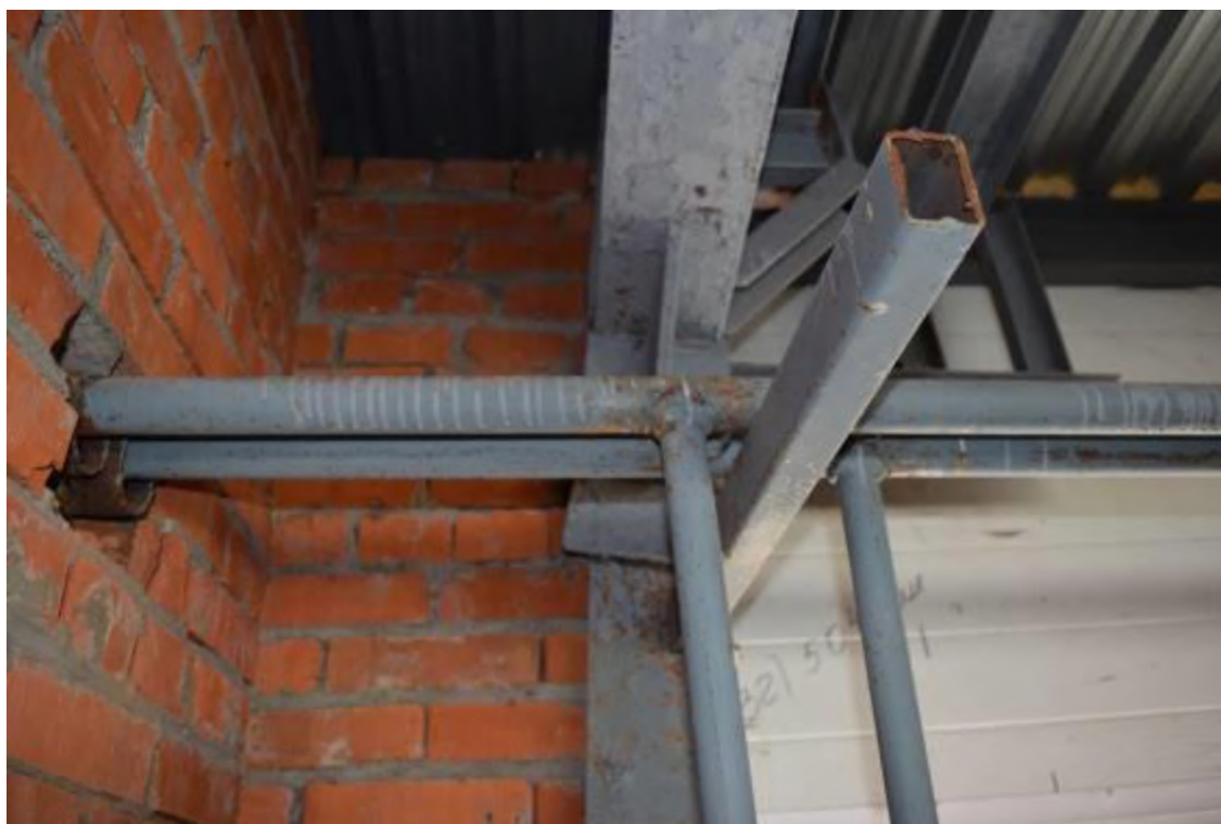
Фото 9. Перекосы металлоконструкций.
