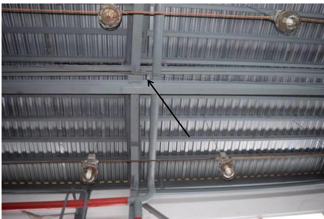
Фото 6. Перекосы металлоконструкций.
